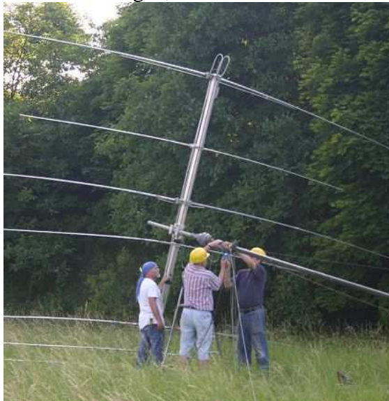
Der Beam wird auf den Mast montiert.
