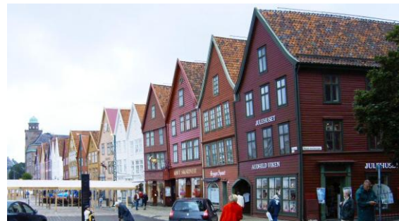
Alte Speicherhäuser in Bergen
